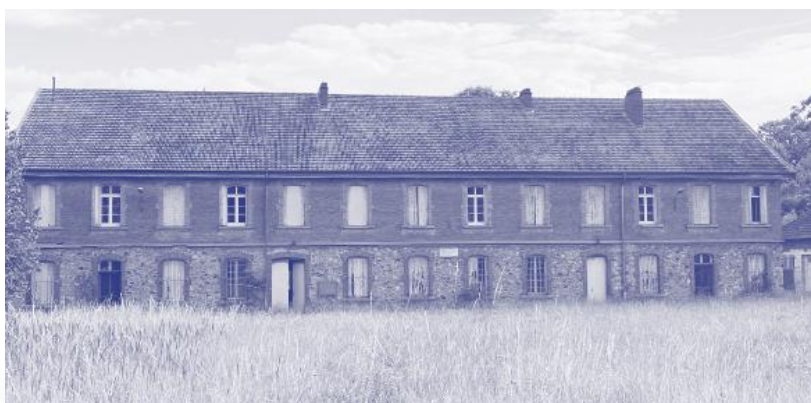
Vue générale de la caserne
