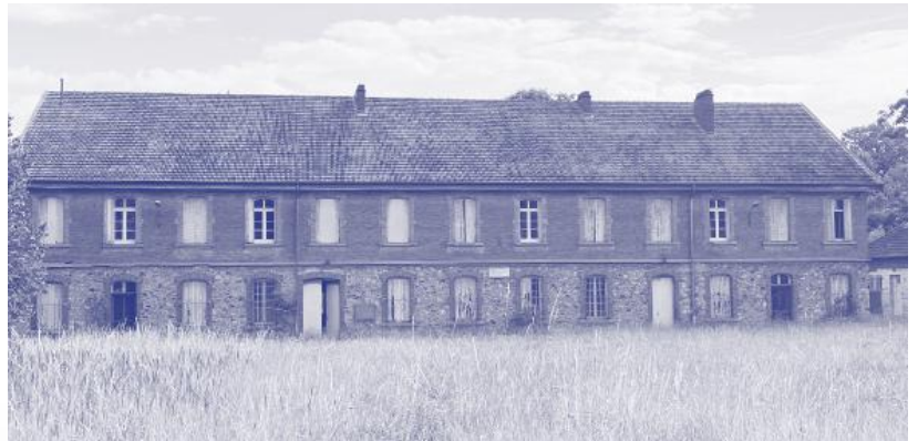
Vue générale de la caserne
